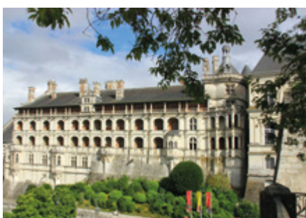
Façade des Loges de l'aile François I er – Côté ville
