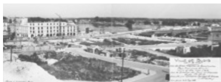
Blois, vue de divers chantiers de reconstruction, 8 septembre 1948 Jean Chartrin
