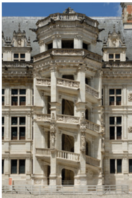
Escalier de l'aile François I er – Façade côté cour
