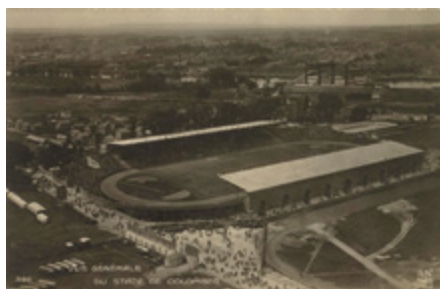
Vue générale du stade de Colombes prise en avion, 1924
