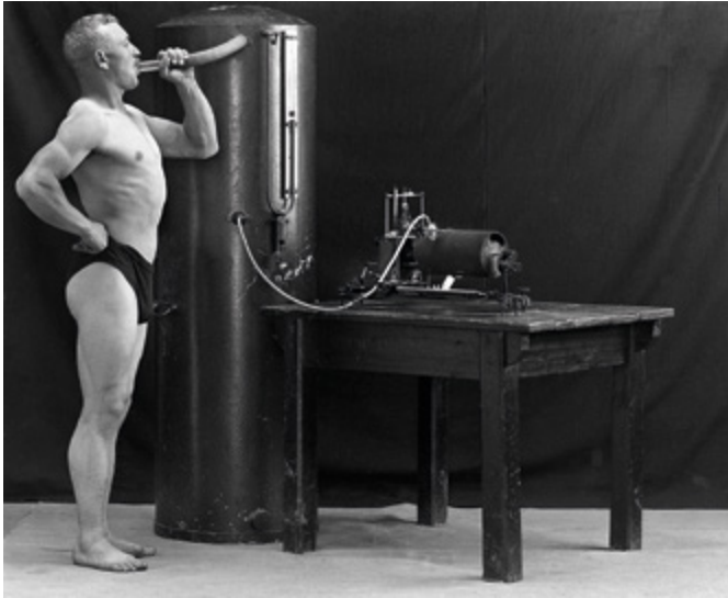
Analyse de l'air expiré d'un sujet à l'aide d'un spiromètre enregistreur à capacité fixe, vers 1906
