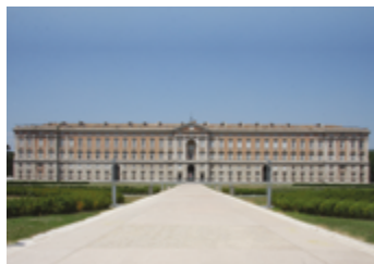
La façade principale
