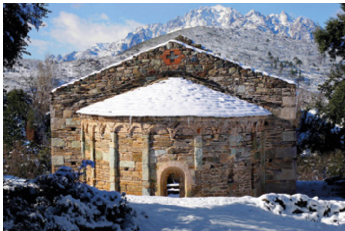
Église pievane de Santa Maria de Rescamone (Valle-di-Rostino, Haute-Corse), 2009
