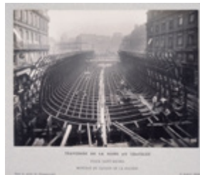
Charles Maindron Construction du chemin de fer métropolitain municipal de Paris, traversée de la Seine au Châtelet, Place Saint-Michel, montage du caisson de la station, vers la porte de Clignancourt, 16 juillet 1906
